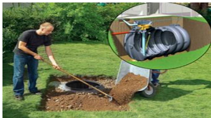
Figure 4 : Citerne enterrée en polyéthylène (Système D).
