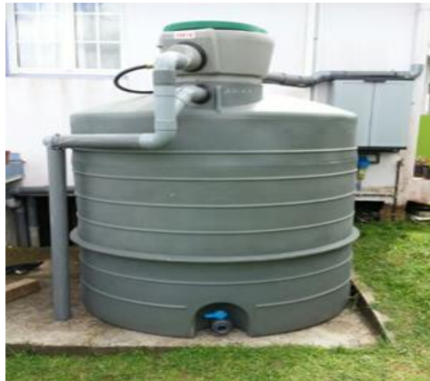
Figure 5 : Citerne aérienne (Pluton Energie SARL).
