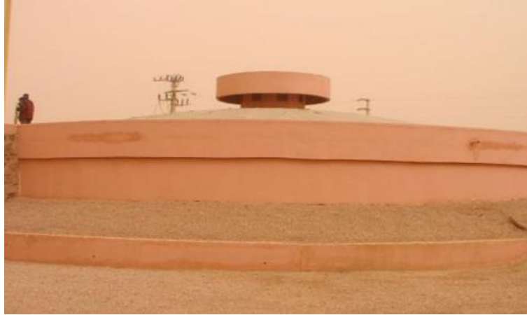
Figure 2 : Réservoir d'eau potable en béton armé semi-enterré (Sahara Développement).
