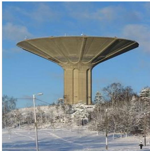
Figure 3 : Château d'eau surélevé (Wikipédia).
